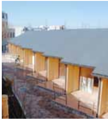
▲新設された緩和ケア病棟
